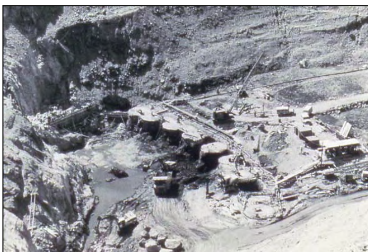
Fig. 12.- Vista general de la ataguía en fase avanzada
