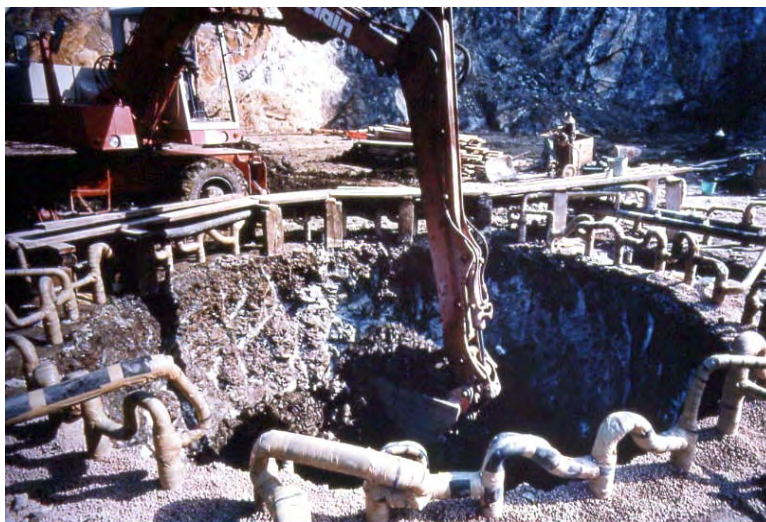
Fig. 11.- Excavación de un módulo cilíndrico con cuchara
