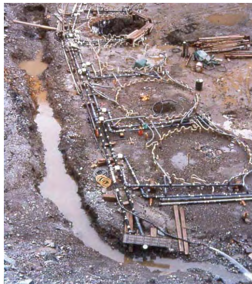
Fig. 10.- Trabajos de congelación. Vista desde la margen derecha
